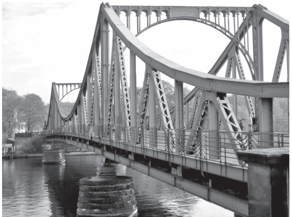
Glienicker Brücke - Brücke der Einheit
