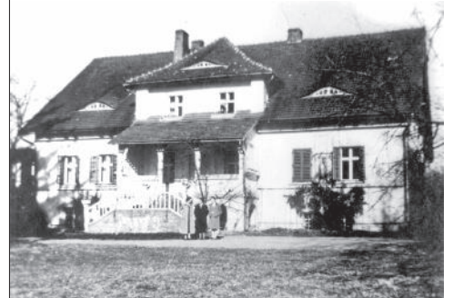
Das Gutshaus in Baumgarten
